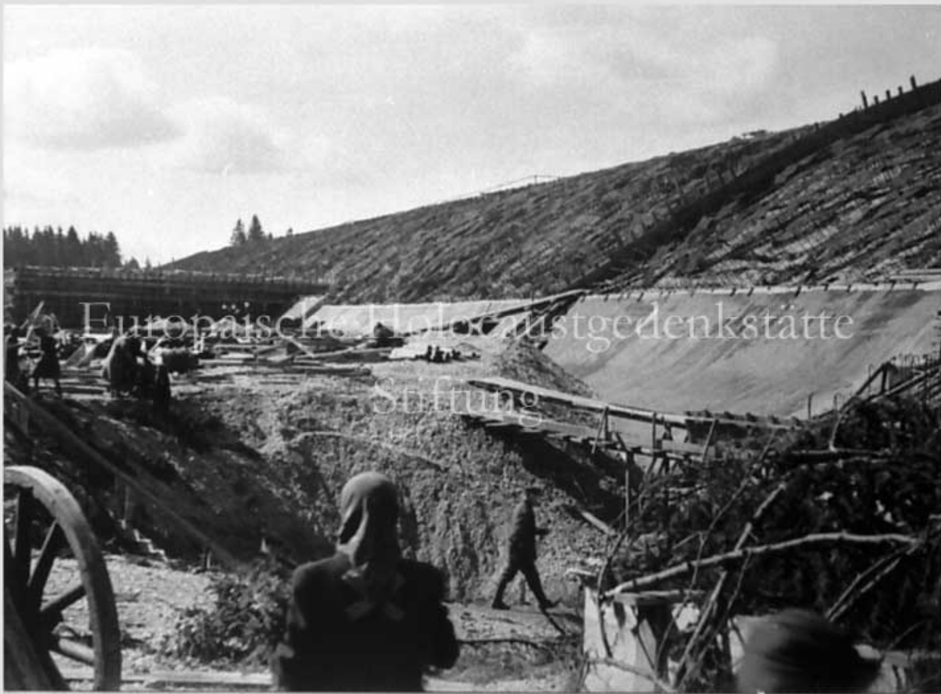
Auffüllung des Widerlagers u. Tarnung der Betonflächen mit Tarnmatten u. Astwerk - Ostseite
